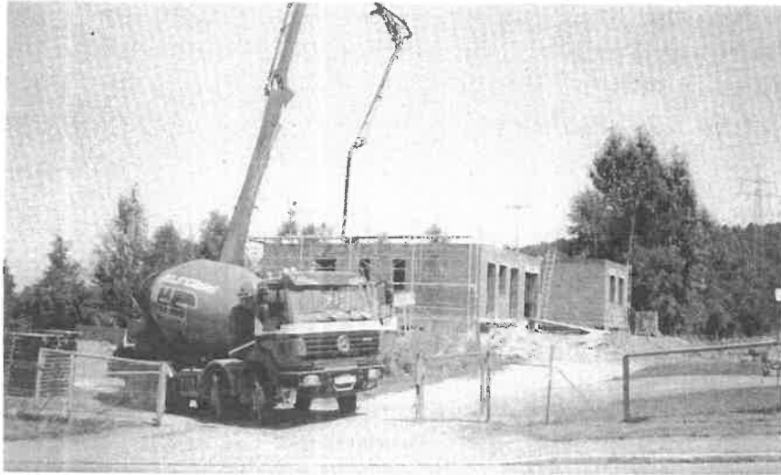
Bereits drei Wochen später, am 21.7.1995, konnte die Erdgeschoßdecke betoniert werden.
