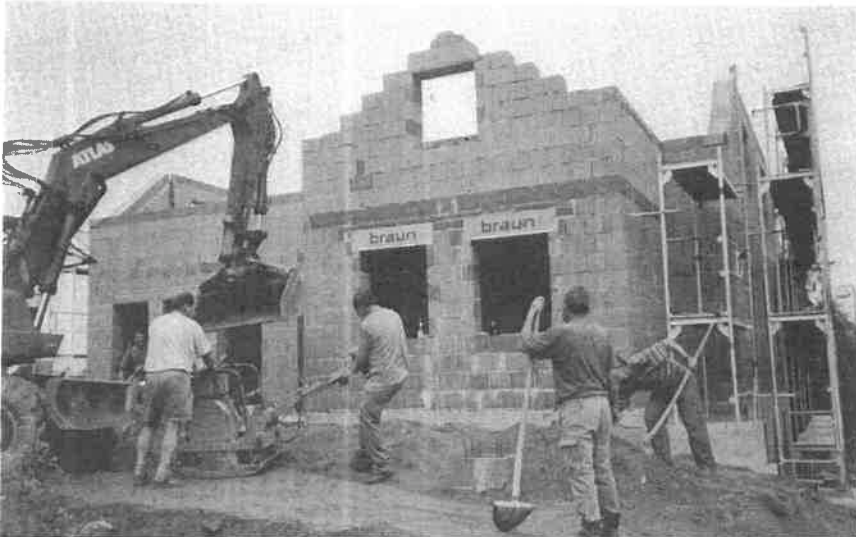
In den nächsten Wochen wurde das Mauerwerk für das Dachgeschoß erstellt und Außenarbeiten durchgeführt.
